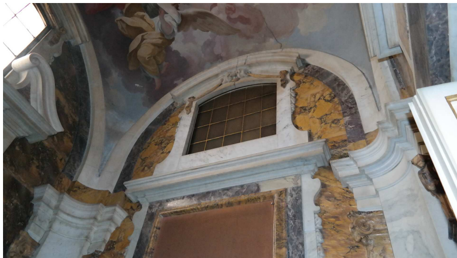
Pareti con rivestimenti marmorei
