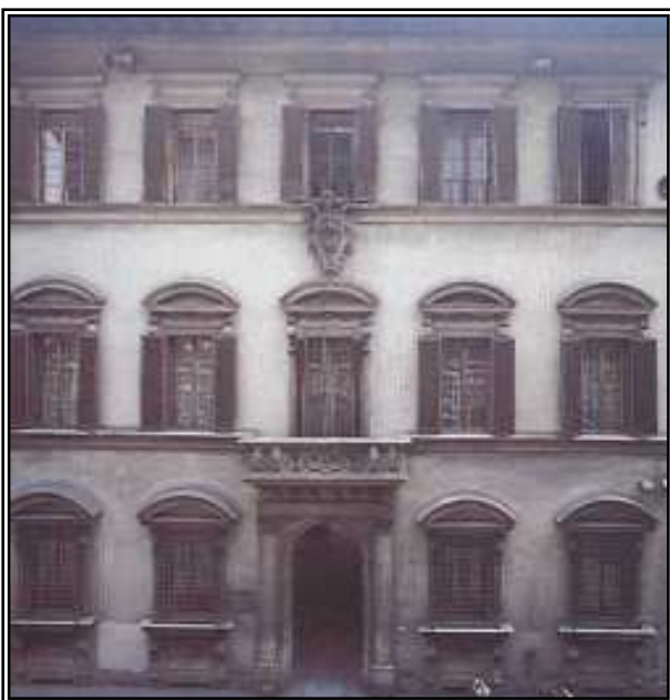
Facciata – via Cavour 4
