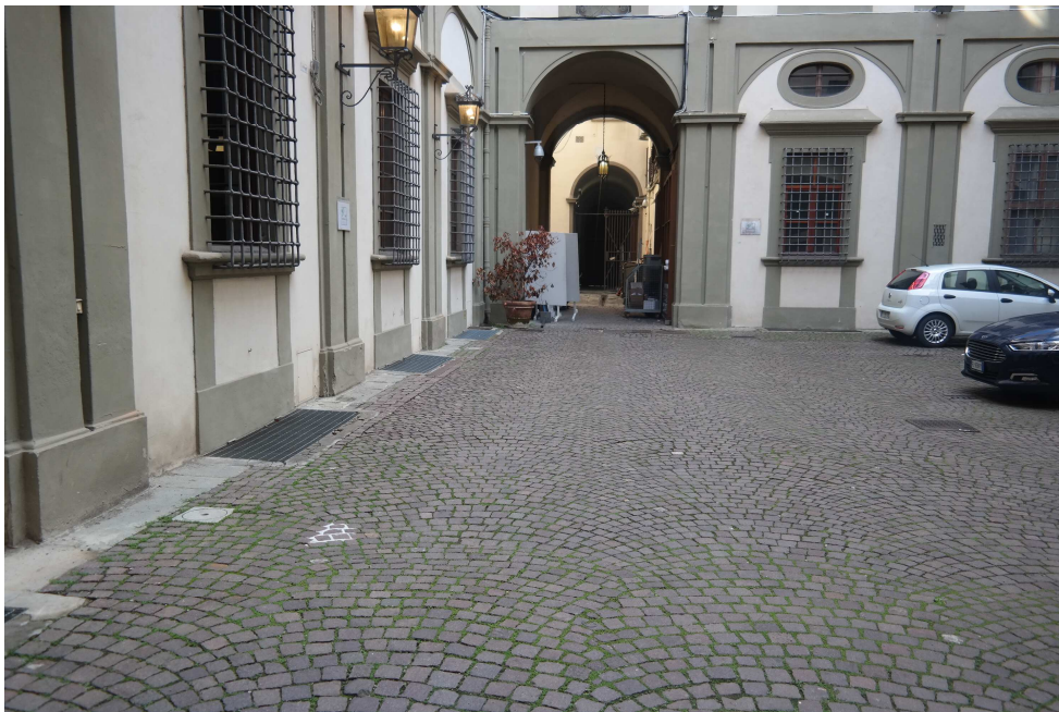
Vista panoramica del cortile
