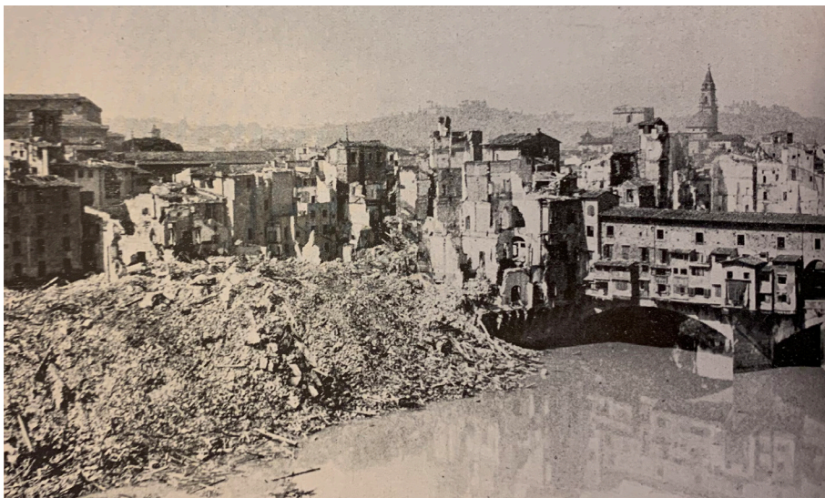
8. Le rovine di via dei Bardi tra il Ponte Vecchio e la piazza di Santa Maria Soprarno. Da «Rassegna del Comune di Firenze», numero unico, 1944-1951
