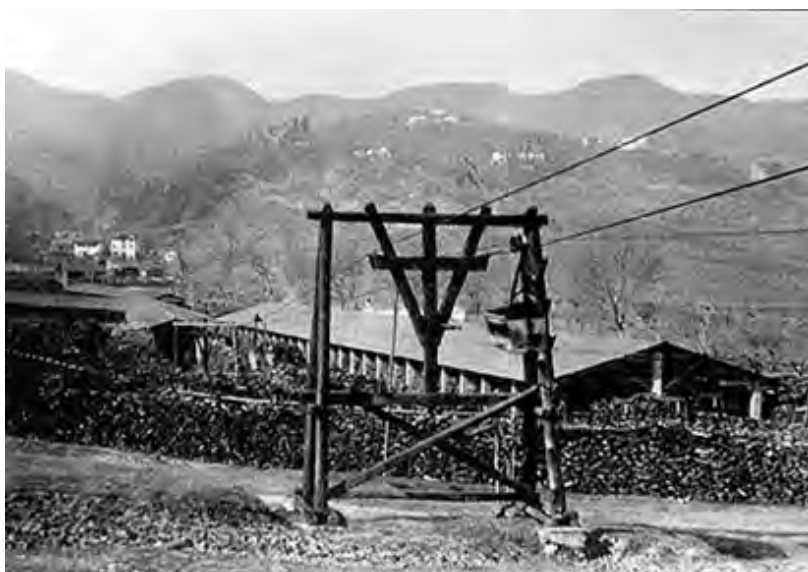
Fig. 5 Teleferica per trasporto lignite dalla miniera di Allori alla centrale Elettrica di Castelnuovo – AAVV
