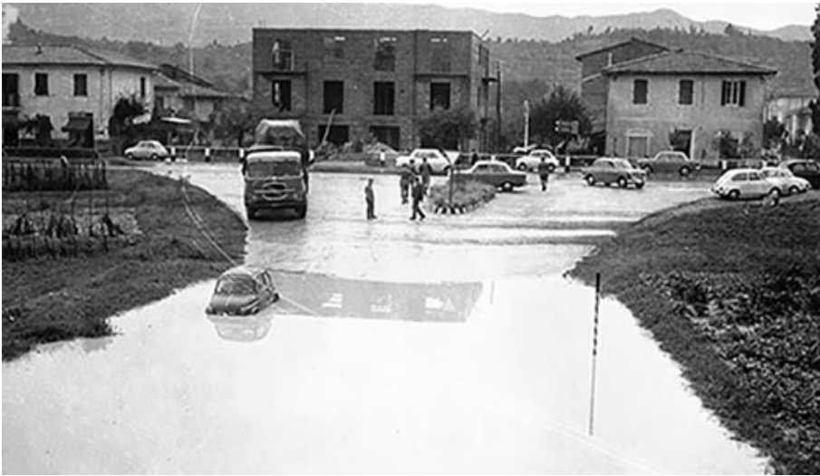
Fig. 55– Alluvione 1966. Zona “Crocce del Papi” Sottopasso per stabilimento Seriom
