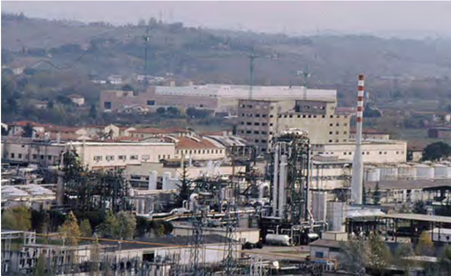
Fig. 67 Impianto Acetati (struttura color ruggine e Costruzione Impianto Anidride Ftalica)
