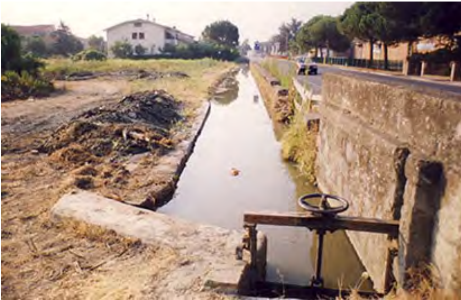
Fig.39 Gora punto presa acqua per lo stabilimento.
