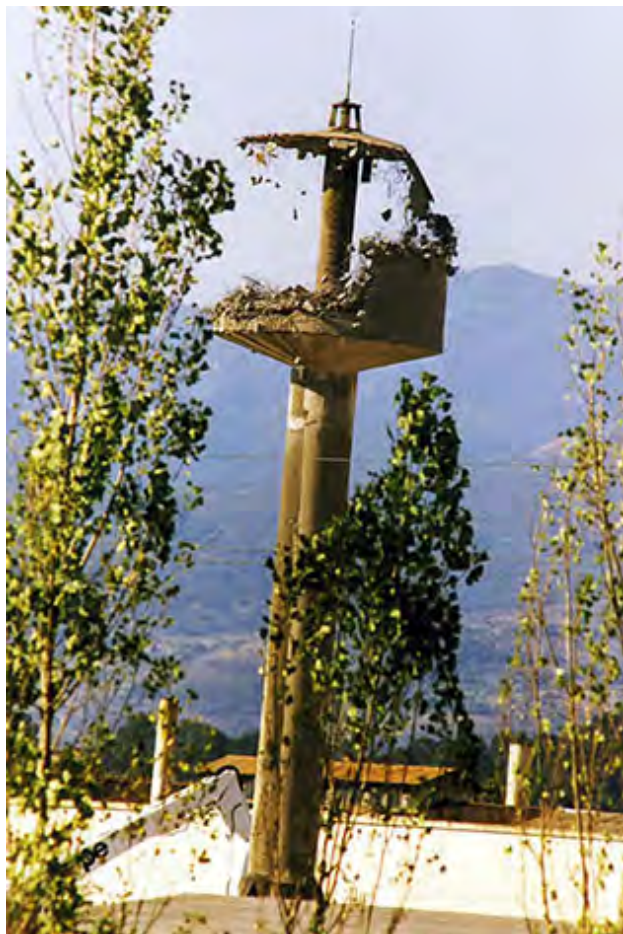
Fig. 96 Fase di abbattimento torre piezometrica
