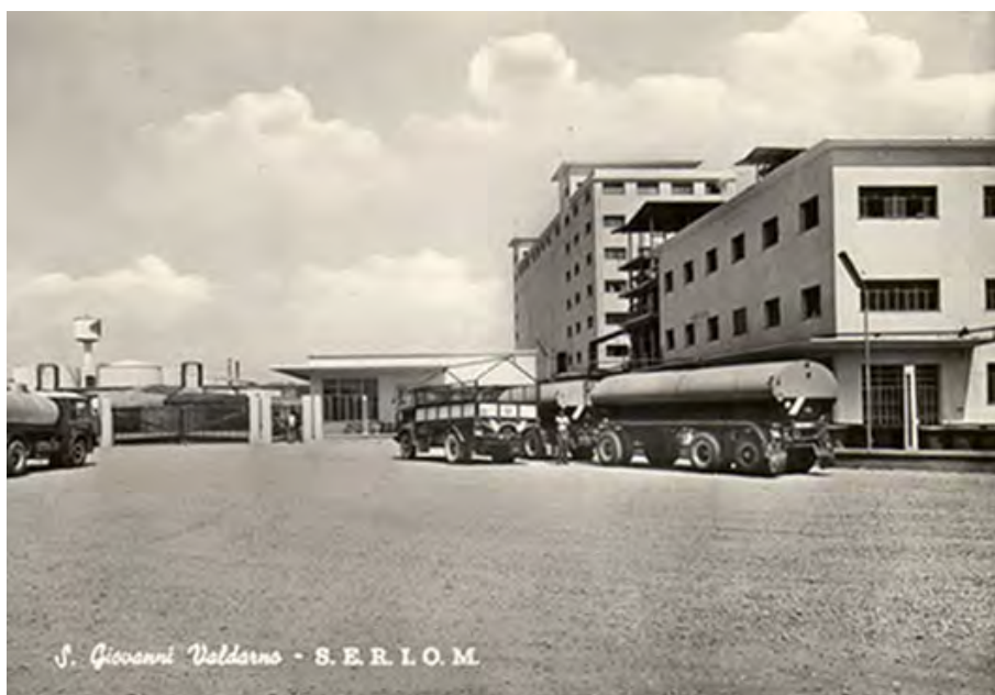
Fig. 45 Nella foto a destra si vede in primo piano il reparto raffineria olio di soia con adiacente la struttura in metallo dell'impianto di estrazione dell'olio di soia. A seguire l'impianto silos ultimato
