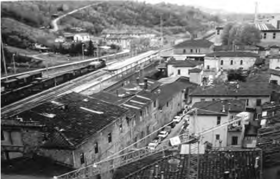
Fig.18 Panoramica stabilimento ceramica "Irostone". AAVV
