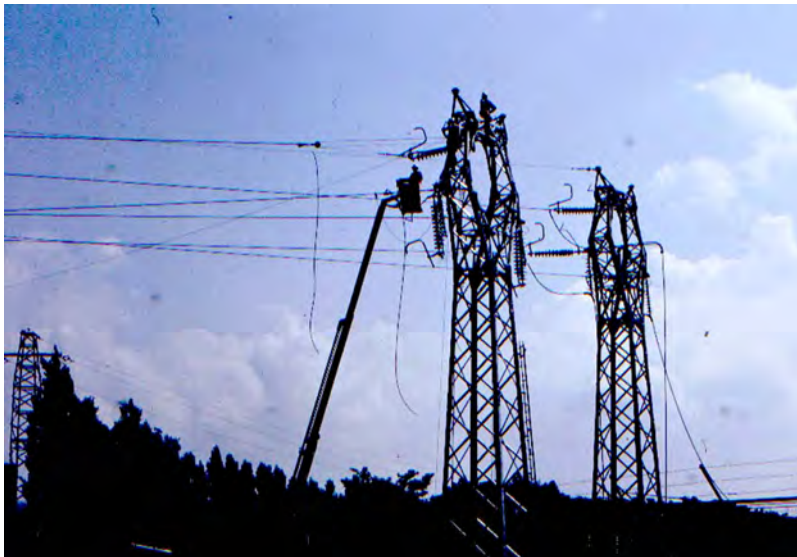
Fig. 76 Interno stabilimento costruzione 2° traliccio (1987 E.E. da 130 KV e trasformazione a 15KV)
