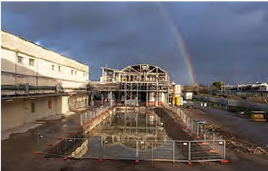
Figg. 108 e 109 Sequenza fotografica demolizione edificio Silos. (Archivio Polynt SGV)
