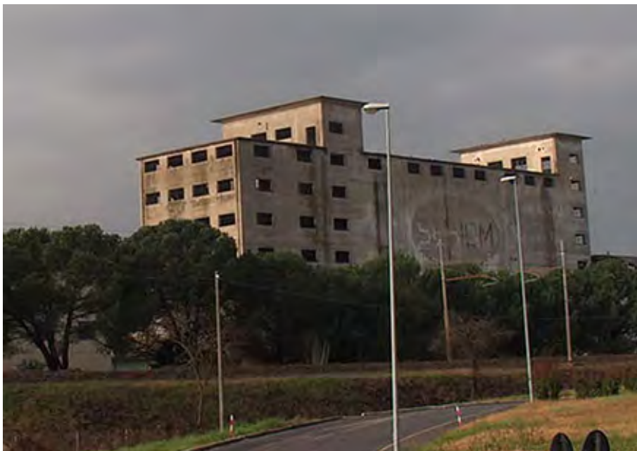
Fig.42 Silos costruzione completa – Visione lato Est
