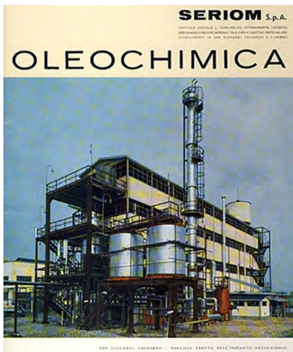
Fig. 52 da Opuscolo tecnico/commerciale con immagine impianto Oleochimico, primo piano colonna di rettificazione alcool Metilico
