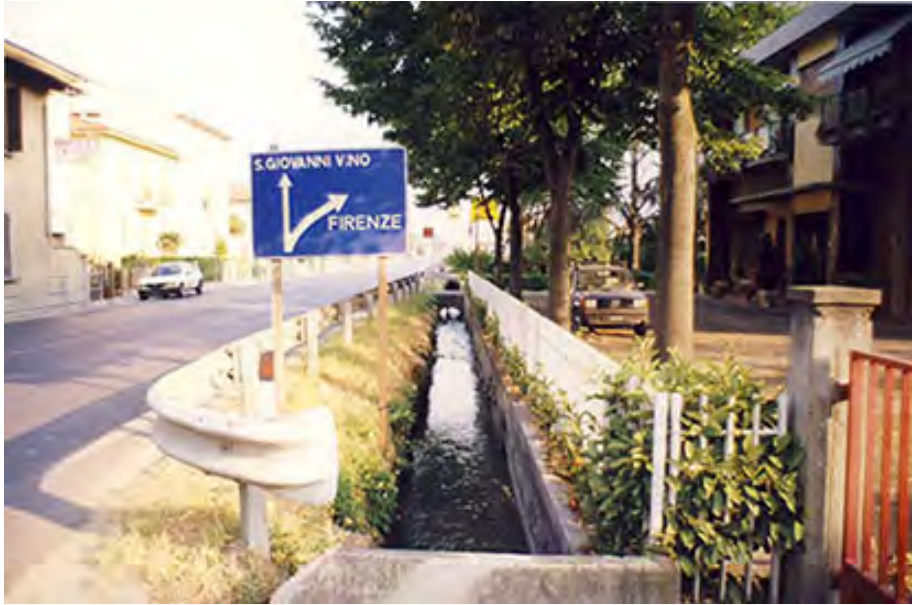
Fig.38 Percorso della Gora dopo la presa di acqua per lo stabilimento.
