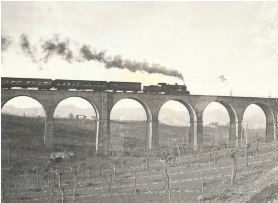
B2 - Il treno sul viadotto della tratta ferroviaria Borgo San Lorenzo- Faenza, inaugurata il 23 aprile 1893 (Archivio Aldo Giovannini)
